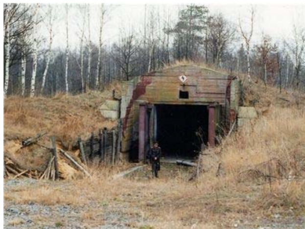
Das war der Eingang in den Atombunker der Westgruppe der sowjetischen Streitkräfte auf dem Truppenübungsplatz Königsbrück.
